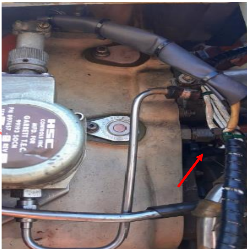
Imagen 6. Cableado del conector de torque Limiter bypass Valve reparado YV3438.
