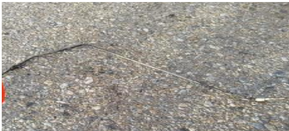
Figura 8. Tubería Hidráulica que presentaba la Fuga, Motor N°2 YV2792. Fuente: Investigadora Encargada. Año: 2026
