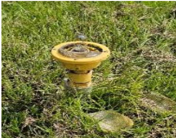
Imagen 4. Daños en la Baliza Fuente: Investigador Encargado. Año: 2026
