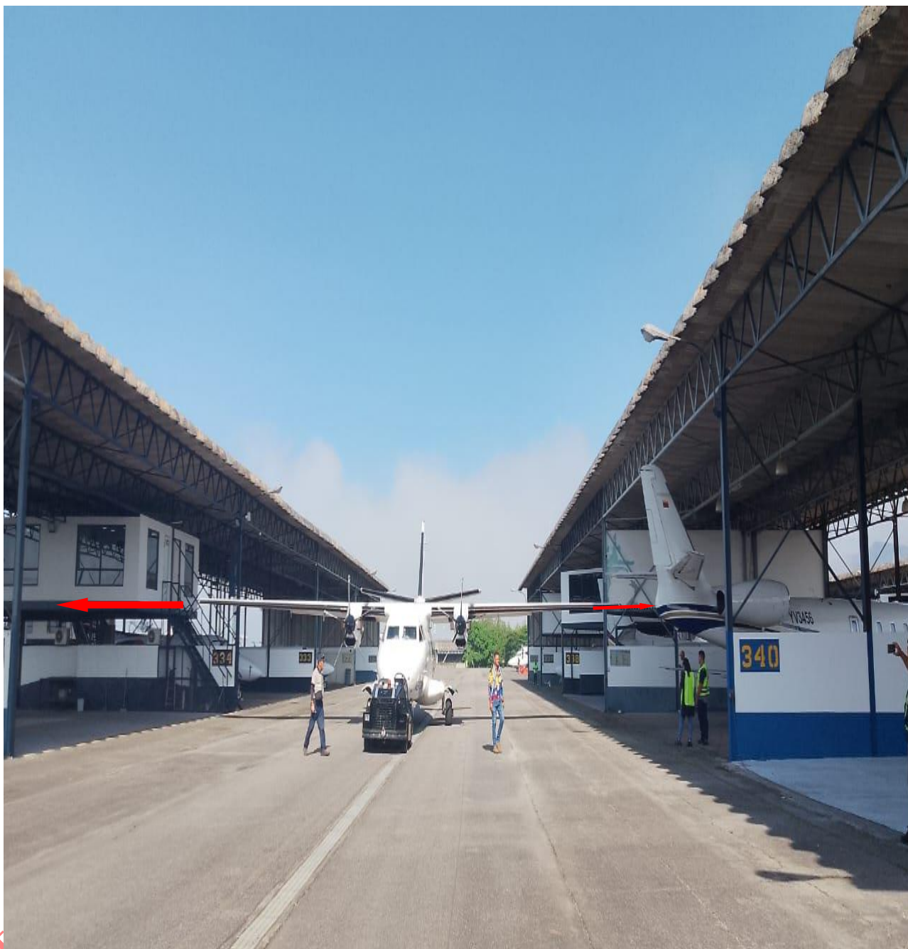
Figura 2. Referencia del paso de la aeronave en el lugar del impacto. Fuente: Investigador Encargado. Año: 2026
