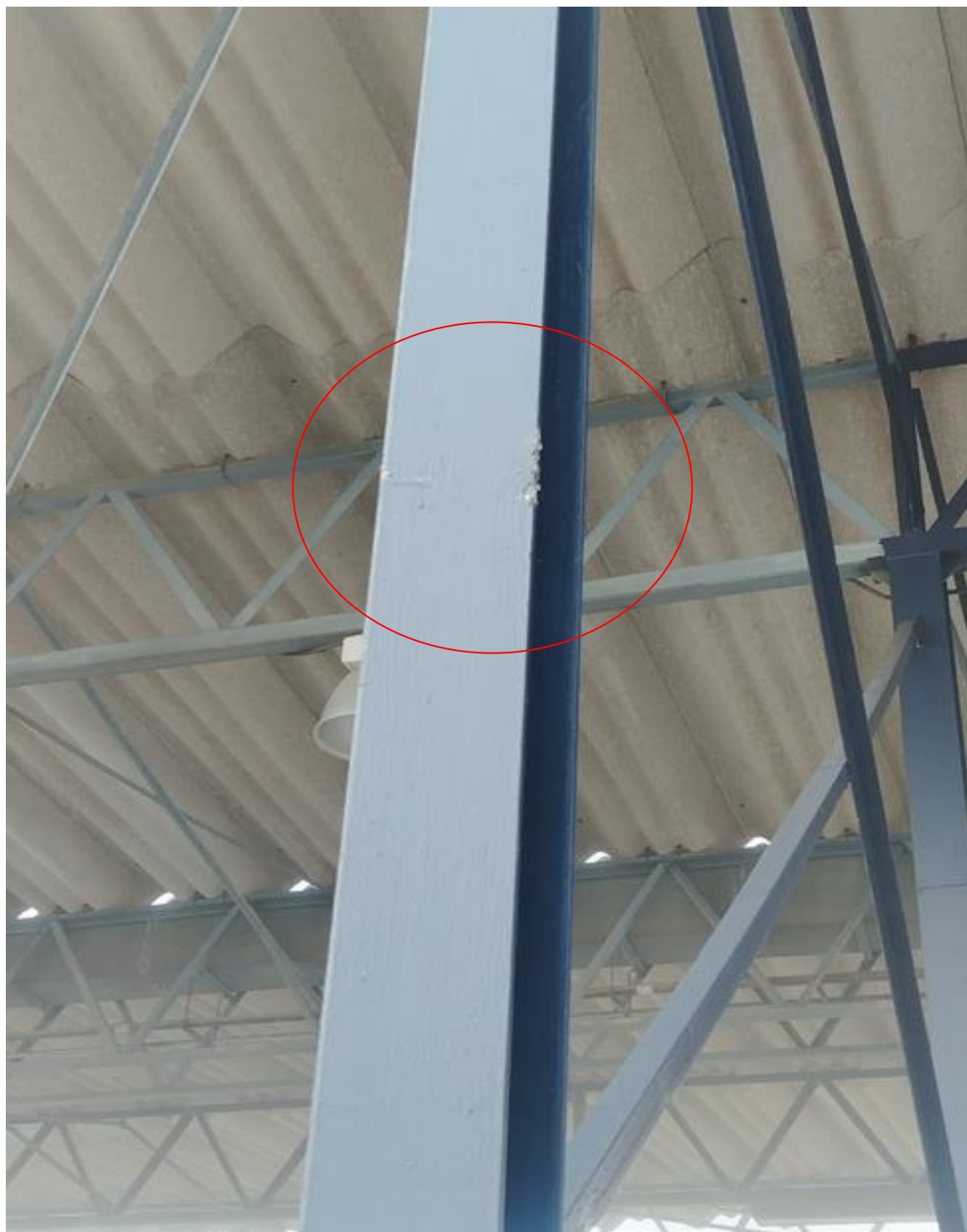
Figura 8. Viga del hangar 334 donde colisionó el plano derecho de la aeronave YV2027. Fuente: Investigador Encargado. Año: 2026
