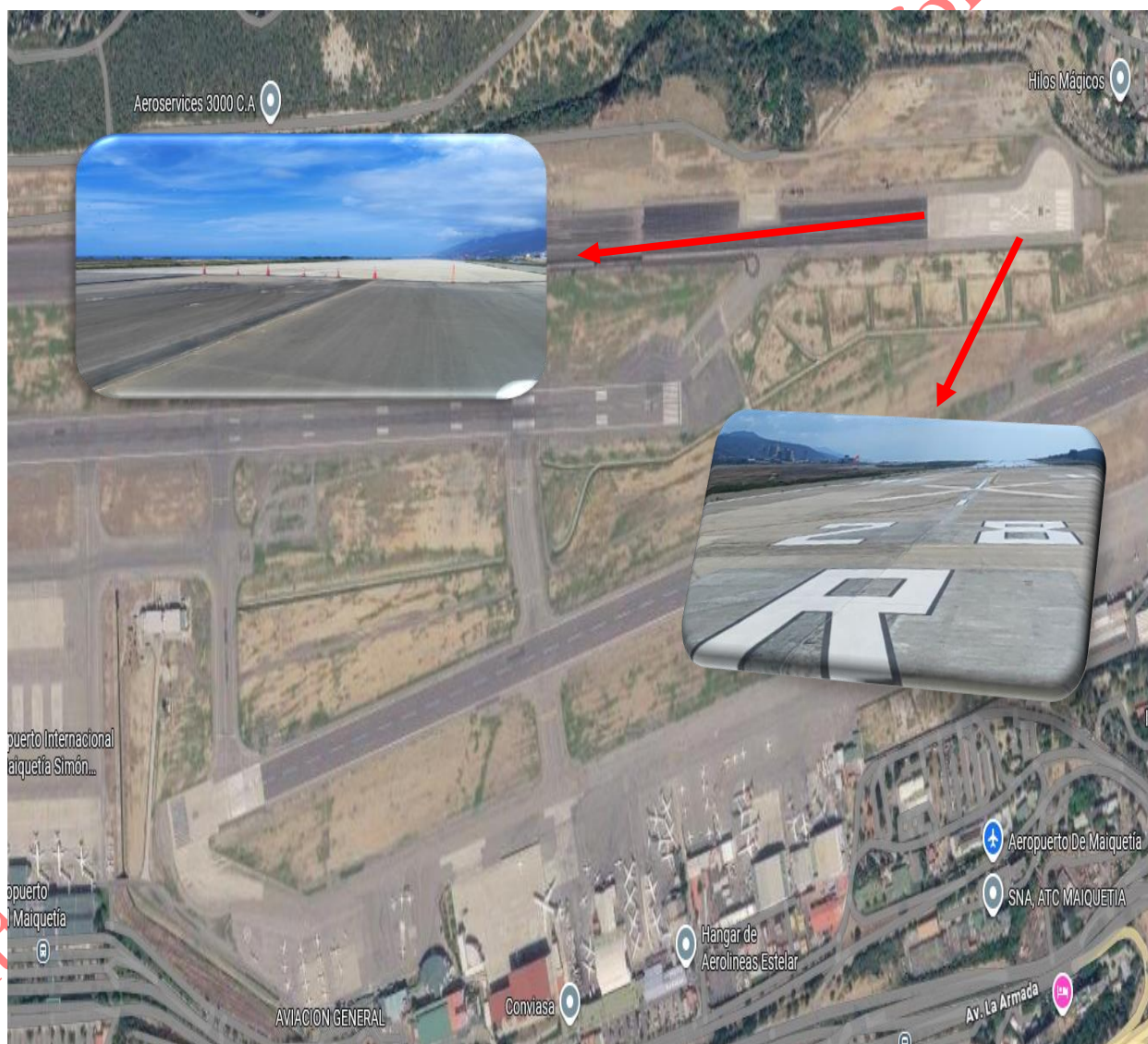
Imagen 2. Aeropuerto de Maiquetía pista Cerrada RWY 28R.(SEÑALIZACIÓN)
