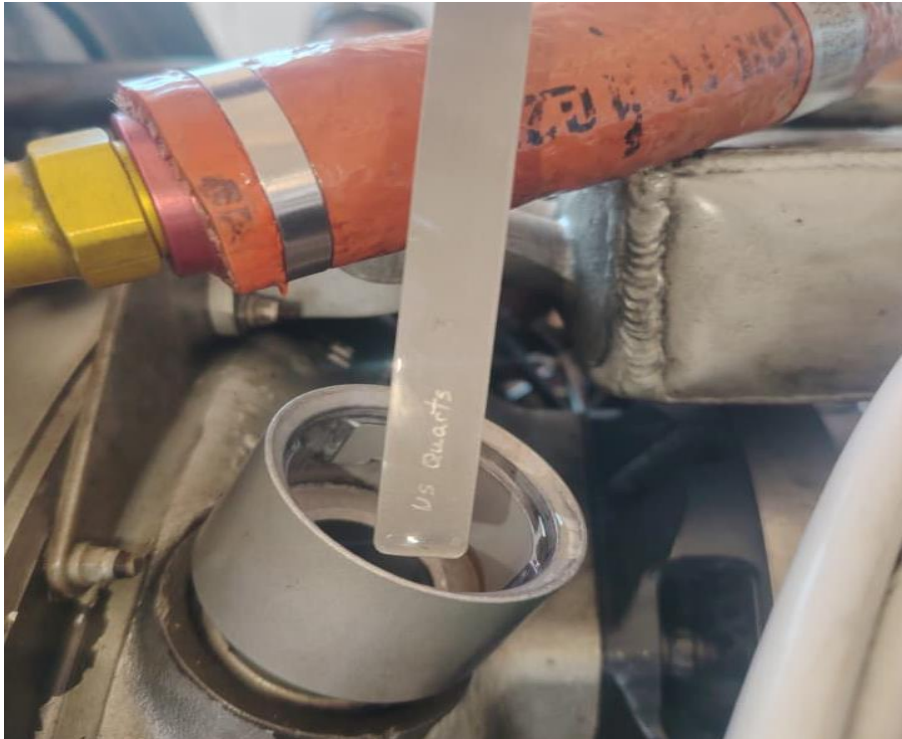
Imagen 7. Inspección del Nivel de aceite motor LH YV2653.
