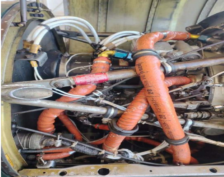
Imagen 3. Inspección del motor LH YV2653.
