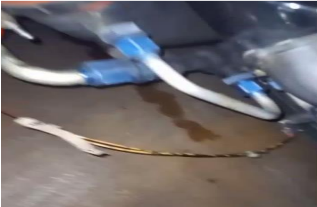
Figura 6: Inspección de fuga de aceite del paquete del Motor Derecho (RH) YV2923
