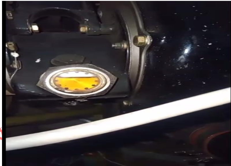
Figura 9: Inspección de fuga de aceite del paquete del Motor Izquierdo (LH) YV2923
