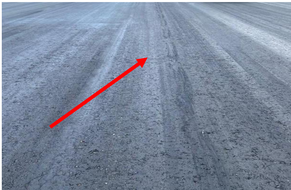
Imagen 13 Marcas de frenado en la pista aproximadamente en la intersección C. Fuente: Investigador encargado. Año: 2025
