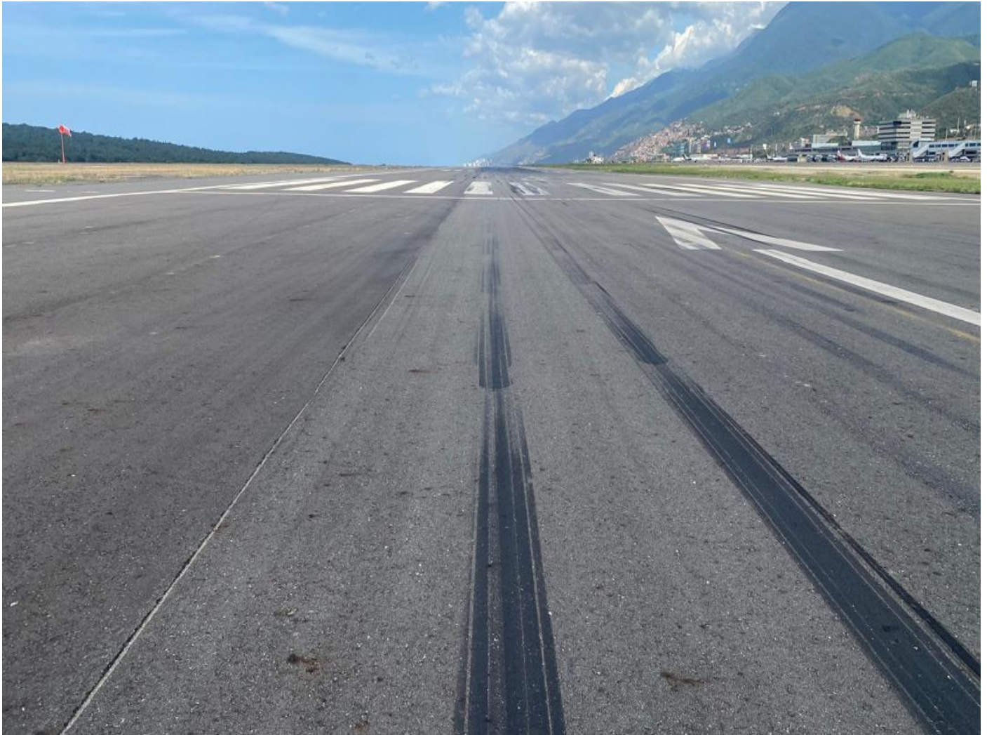
Imagen 17 Marcas de frenado al final de la pista
