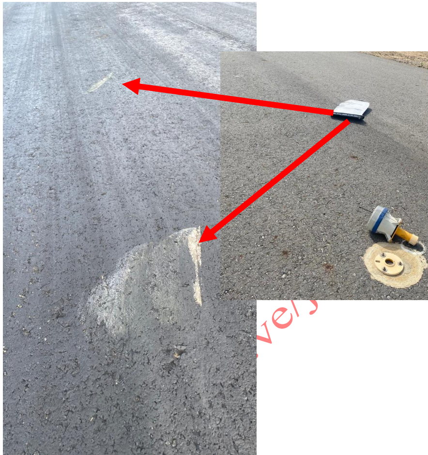
Imagen 15 Marcas de la tapa del tren derecho y luz del balizaje
