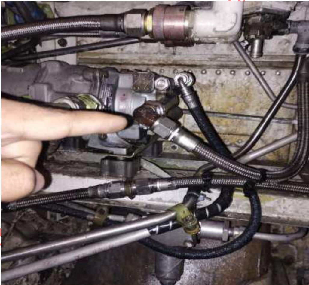
Imagen 2: Fuga Hidráulica del sistema B, aeronave YV2792
