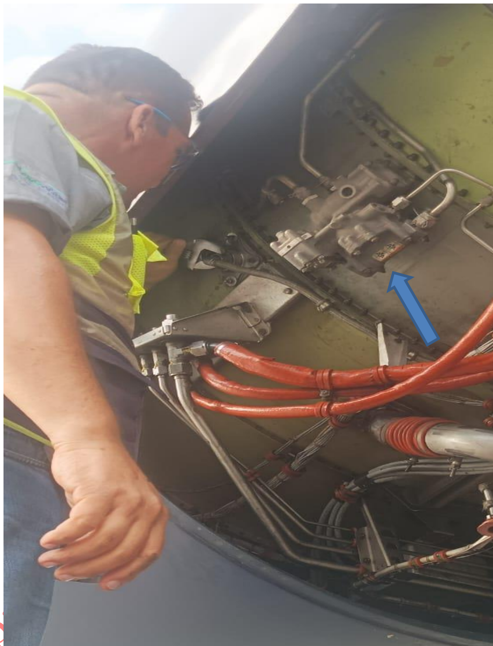
Figura 5. Inspección de la PRESSURE RATIO BLEED CONTROL YV3499 .
