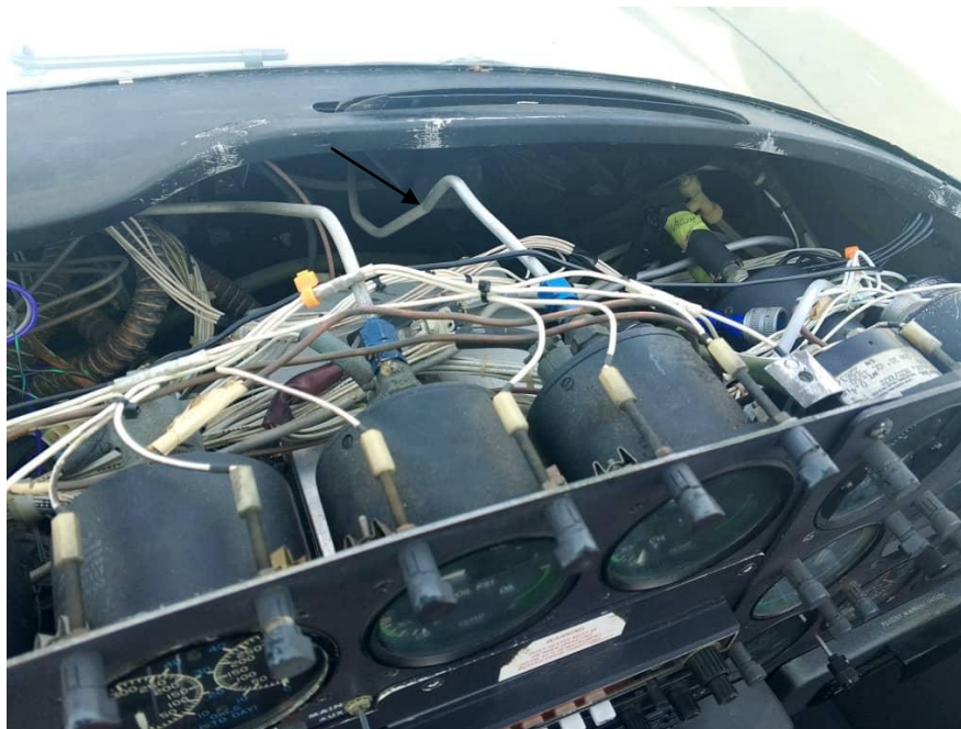
Imagen 2: Cableado equipos de Aviónica YV3105.
