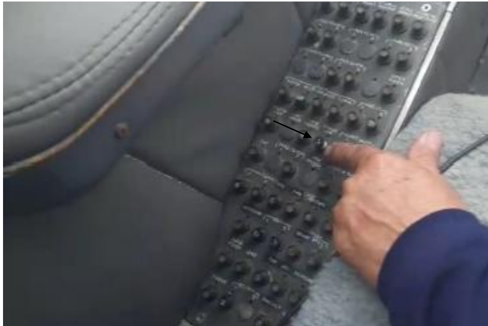
Imagen 5 Breaker del cigarrrete que se activó YV3105. Fuente: Investigador Encargado Año: 2024
