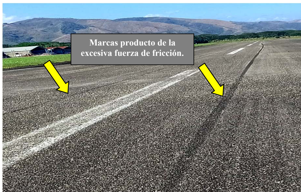
Figura 6. Evidencia de las marcas en la pista por la fuerza de fricción generadas por el contacto del neumático con la pista.
