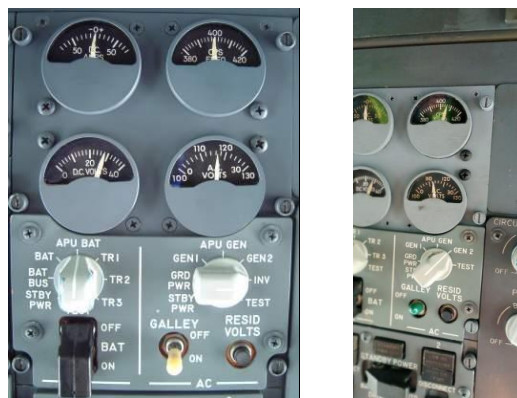
Foto 3. Prueba funcional del sistema eléctrico.
