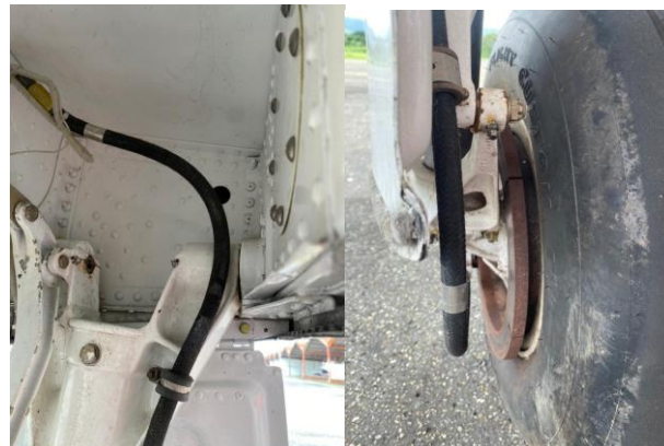
Fotografía N° 4. Inspección preliminar de las Líneas Hidráulicas sin observarse derrame de fluidos Fuente: Investigador Encargado. Año: 2022.
