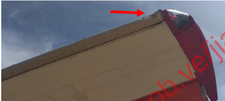
Imagen 1. Inspección Externa de la aeronave YV2773 se observa impacto en el ala izquierda
