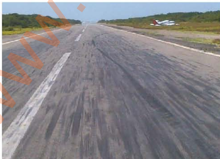
Fotografía 1. Se observan marcas dejadas por el tren principal derecho al momento del contacto inicial
