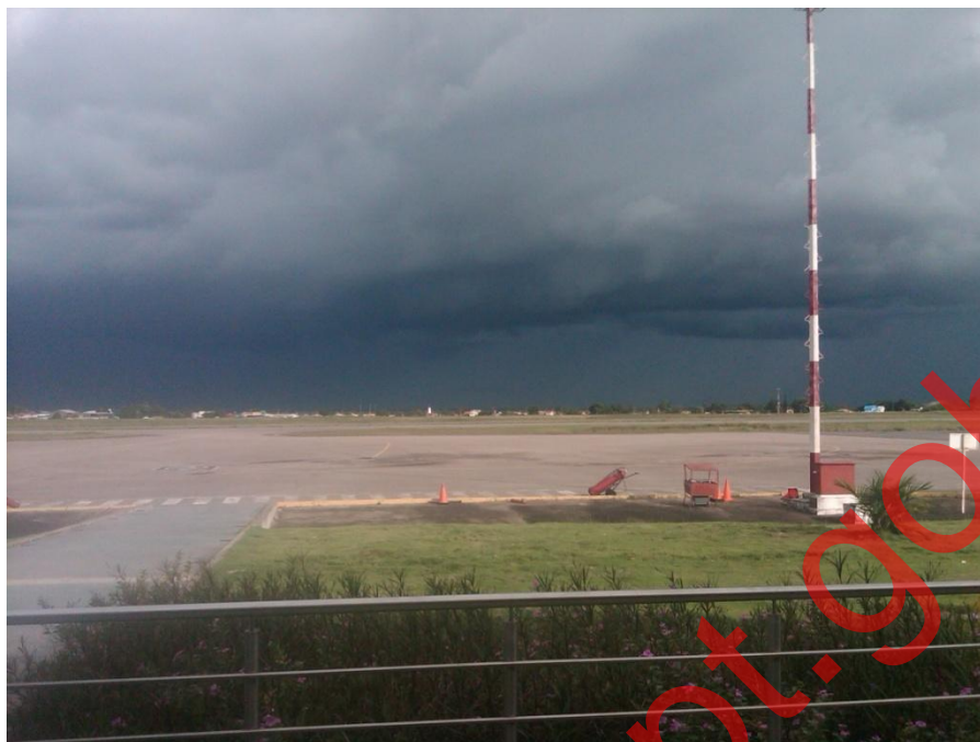
Fotografía 3. Plataforma y pista de aterrizaje antes del incidente. Fuente SAADEMO (2012).
